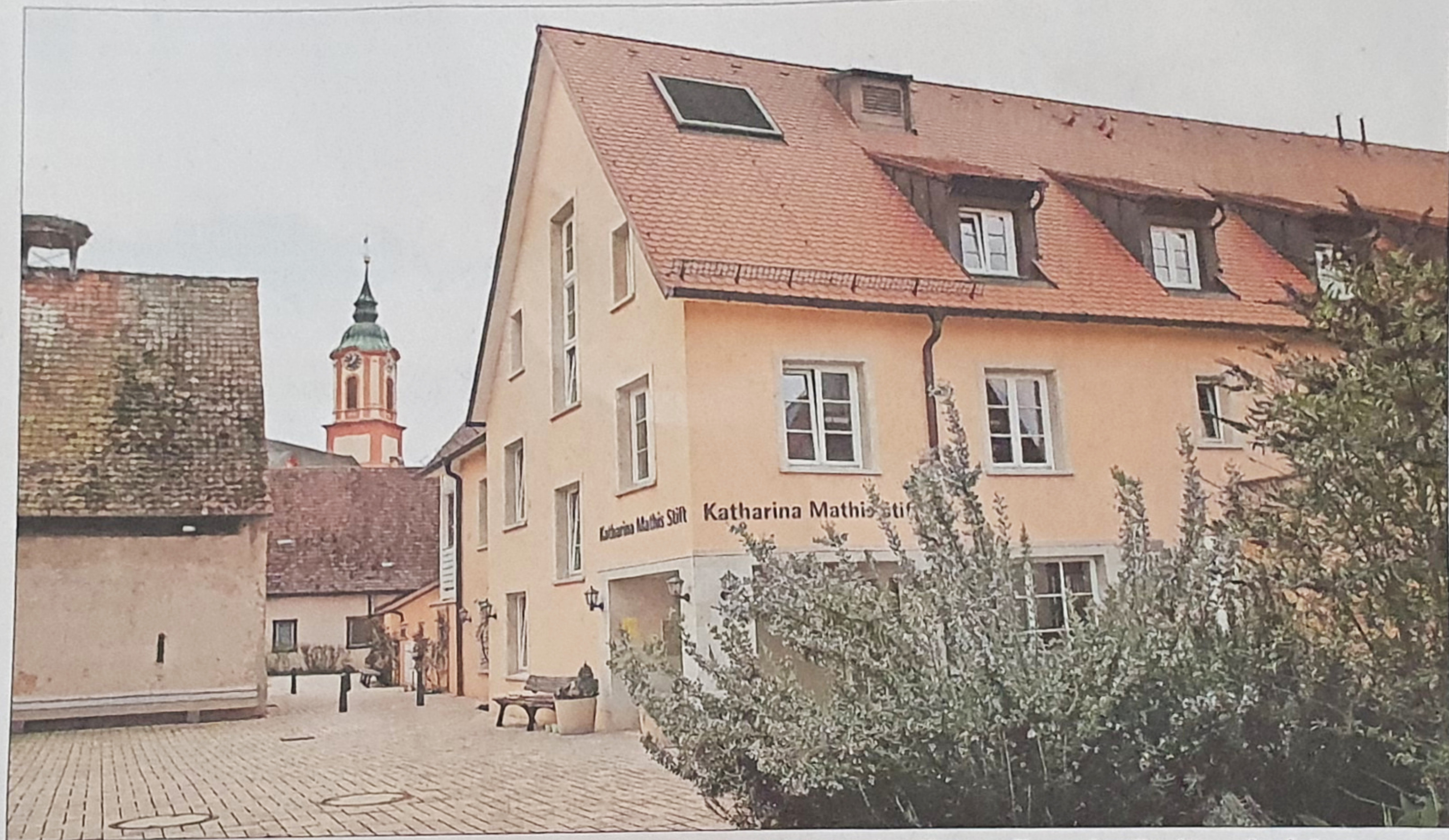
im Dachgeschoss des Katharina-Mathis-Stifts in Merdingen könnte eine Tagespflege der Caritas einziehen.
